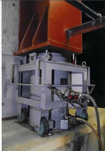
倉庫建物には「不同沈下修正構法」を採用。108本の柱が土台と切り離され、必要に応じてジャッキアップすることにより、埋立地独特の地盤沈下対策に備えている。
