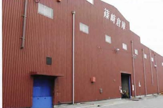
神戸市民の台所、神戸市中央卸売市場と隣接する兵庫突堤内に、物流拠点を構える篠崎倉庫株式会社
