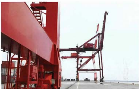
18番バースにはさらに3基のクレーンが新設される予定。オペレーターの活躍の場は今後も増えそうだ。
