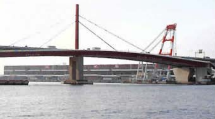
HAT神戸から遠望すると、 左右非対称の構造がよくわかる
