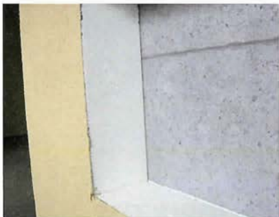
外断熱工法の構造模型の一例。コンクリートが断熱材に包まれている
