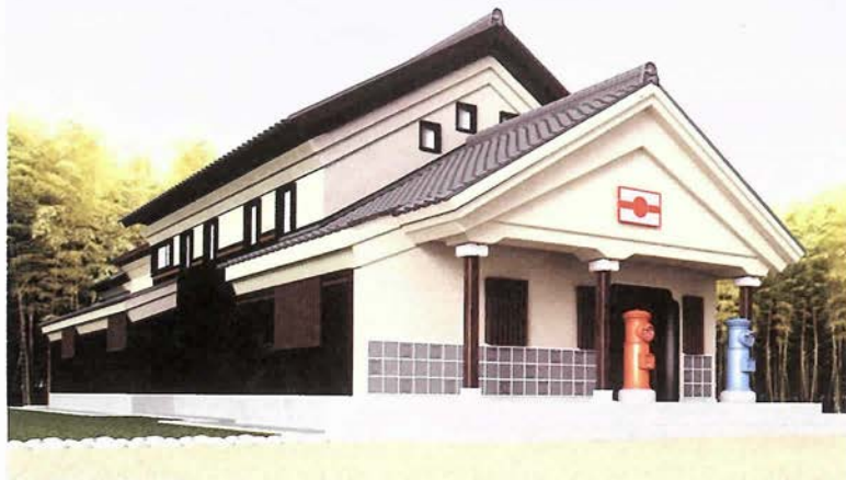
博物館の建物は、約300年前の土蔵造りの建物を岩手県から移築した(写真は完成予想図)
