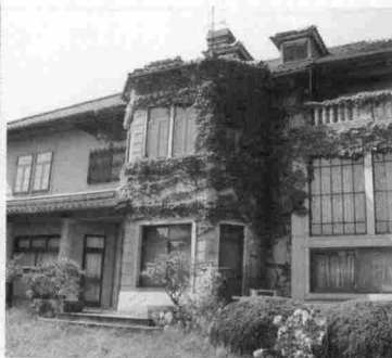
旧乾邸は昭和11年、渡辺節の設計で、乾汽船の初代社長、乾新兵衛邸として建てられたRC造及び木造2階建ての住宅。
