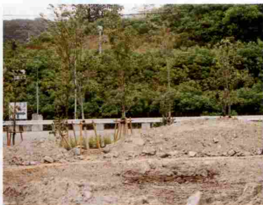
↑子供たちが参加して造りはじめたピオトープ ←高さ12mの風力発電装置
