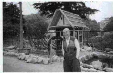
先生の後ろが建設中の水車小屋。実際米をひく。これから茅を葺く予定
