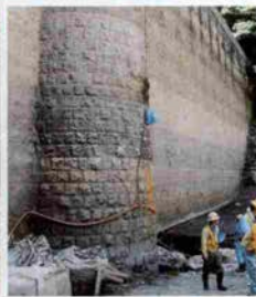
日本最古の重力式コンクリートダム「布引ダム」
