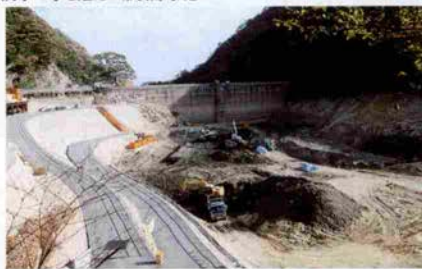
現在、水を抜き工事が進んでいる
