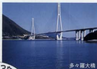
多々羅大橋
