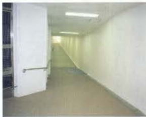
地下連絡通路 安全、確実な動線として手回し幹線地下に、県庁各部署へと続く通路が整備されている
