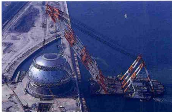
2000年7月末に南港にオープンした「なにわの海の時空館」の建設作業風景。ガラス張りのドームを海からクレーンで吊り上げて慎重に設置する（1999年竣工）
