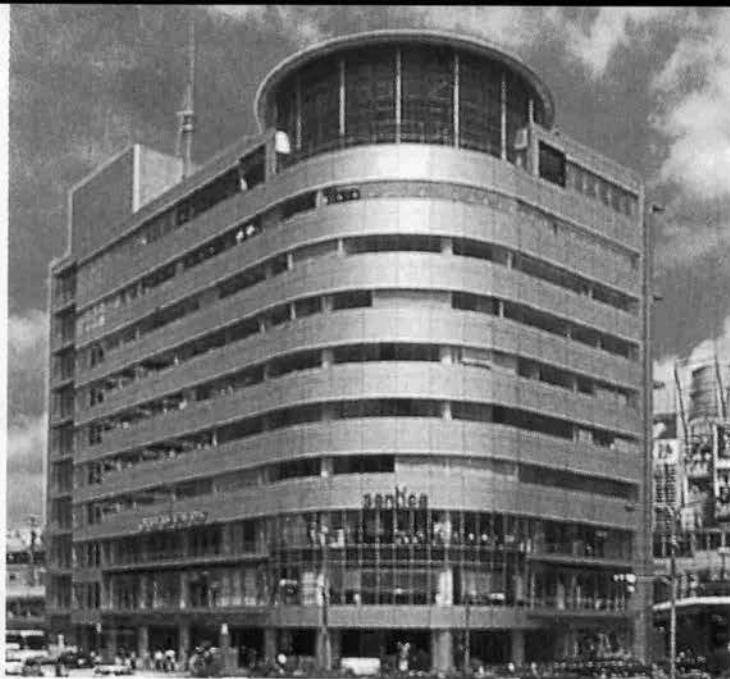
→震災後再建された神戸交通センタービル。すっきりとした外装で三宮駅前のシンボルとなっている
