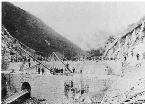
布引貯水池のえん堤工事（明治時代）
