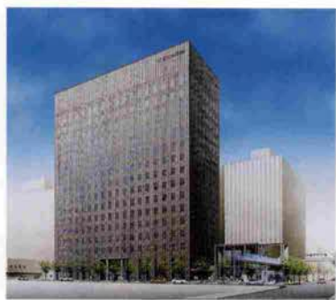
3月10日竣工の「三宮ビル南館」
