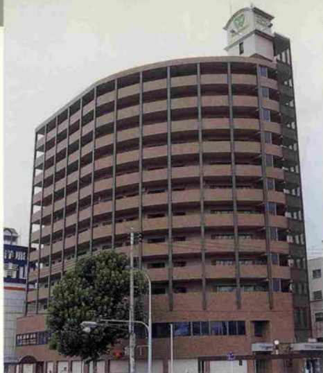
6月に竣工した「ワコーレ長田綜合ビル」
