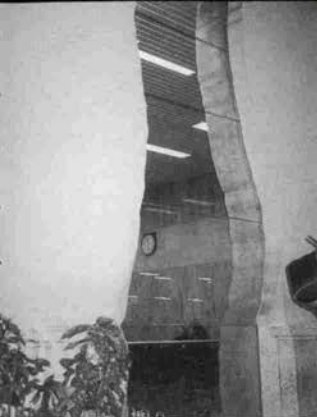
イタリア ボローニャ 駅で1980年8月末確定のテロ集団によってひきおこされた爆破事件で破壊された壁。危険な箇所の壁の補修を行い、ホームと待合室の仕切りの為、ガラスをはめ込み保存した
