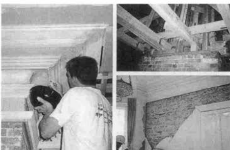
右上：小屋組の部分補強 右下：2階寝室の壁漆喰の落下 左：英国人左官職人による作業
