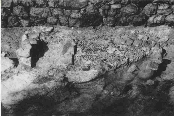
湯ぶねの底には漏水を防ぐため小石や瓦片を粘土で固めてある
