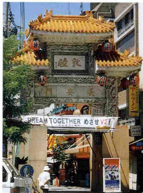
完成に向けて修復中の長安門
