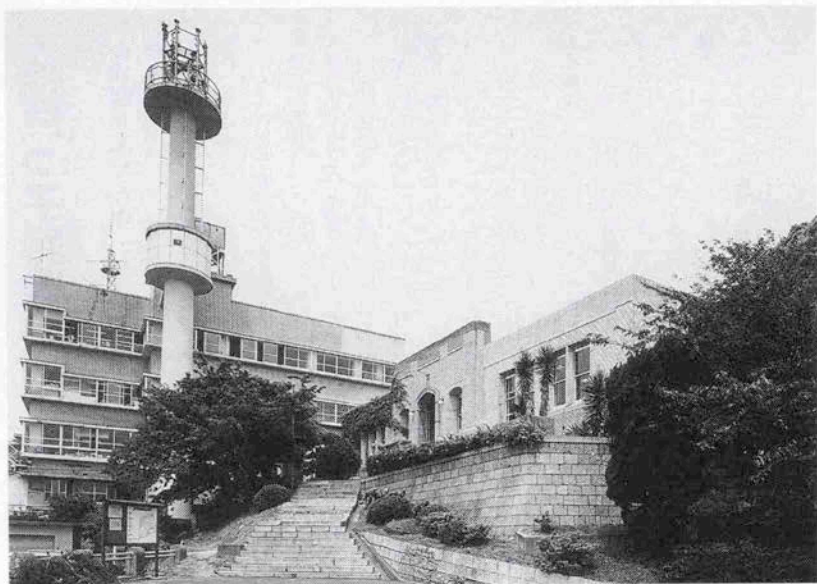
中山手にある神戸海洋気象台は、海洋気象台としては日本最古のもの。測風塔は震災で被害を受けて、取り壊された
