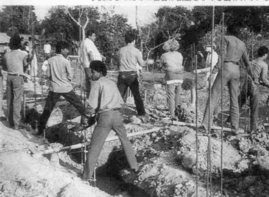
レンガやコンクリートを手から手へ。宿舎基礎工事に会員も参加した
