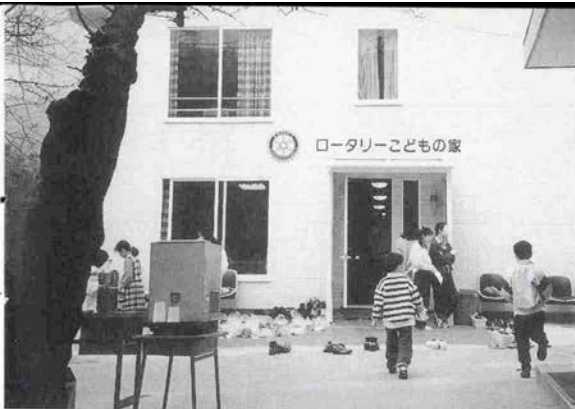
神戸真生塾に建設された「ロータリー子どもの家」
