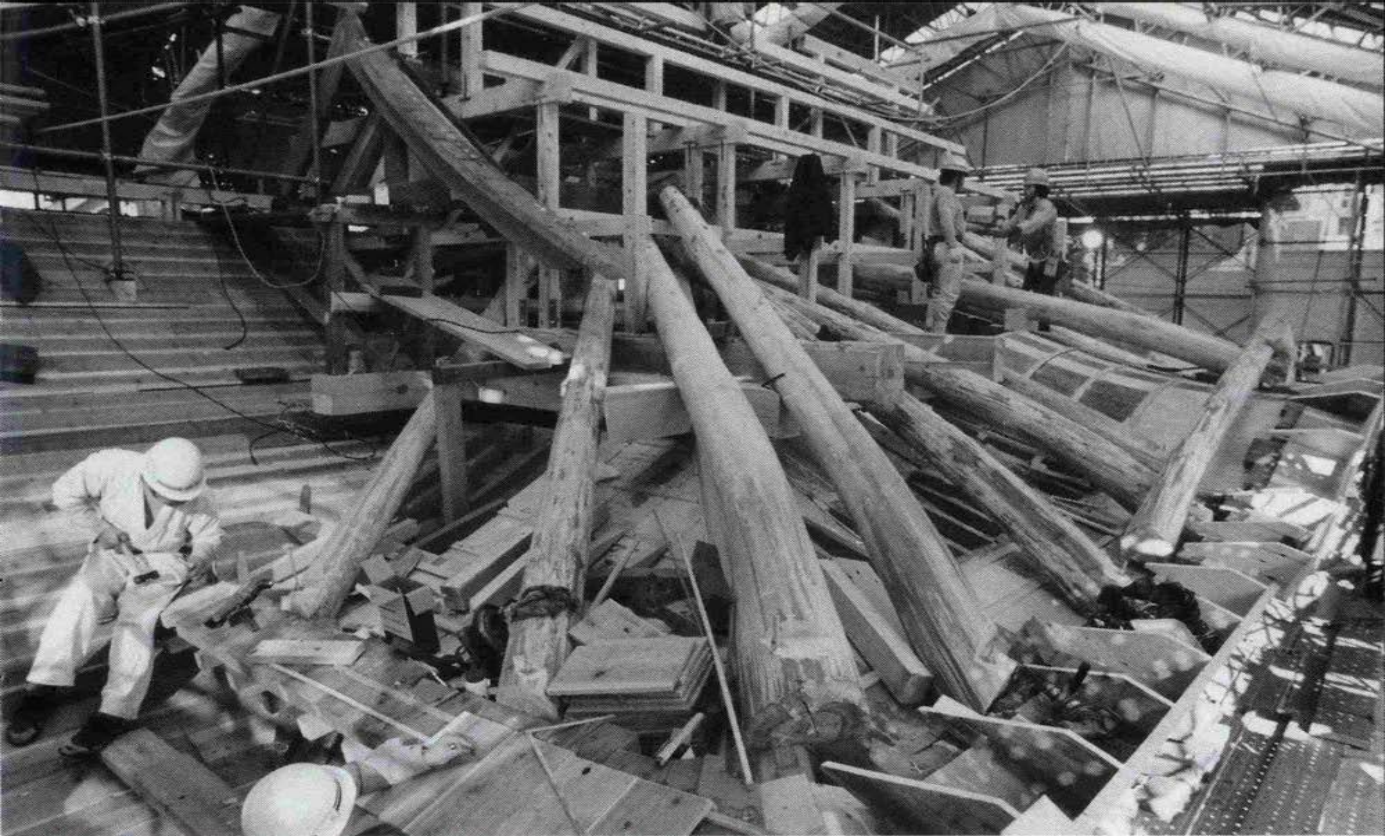
拝殿の屋根組は宮大工による伝統的神社建築が守られている
