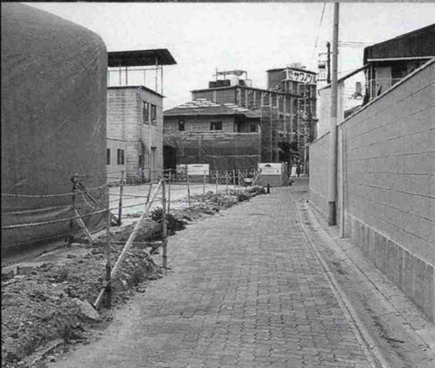
上 忠勇の蔵。こうした蔵が「酒蔵の道」の景観を生み出していた（92年5月撮影） 下 解体され、ブロック敷きの道だけが空しく残る（96年1月）
