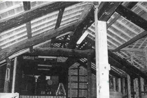
補修された灘泉の蔵。白っぽいのは新しい柱
