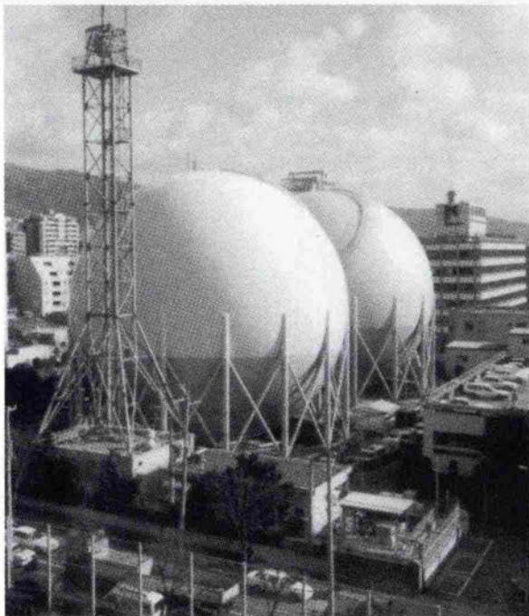
神戸市中央区の球形ガスホルダーは地震にもびくともしなかった
