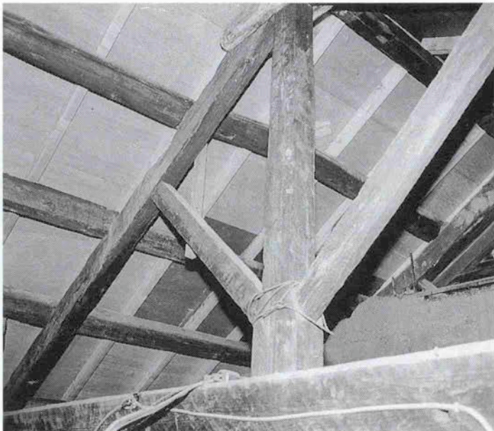
小屋根の架構。キングポストの架構はしっかりとしていた
