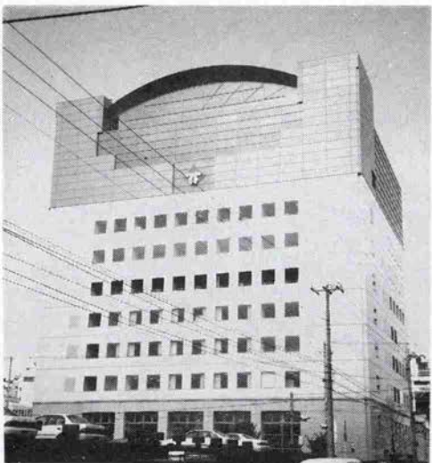
屋上プールのガラスのドーム屋根が特色の 「こうべ市民福祉交流センター」
