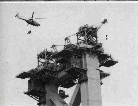
上／舞子側の橋台から飛び立つヘリコプター。 中／現場では200人の作業員が見守る。 下／300mの高さを持つ主塔にロープを固定。
