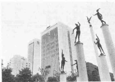
ポートアイランド・ファッションタワー
