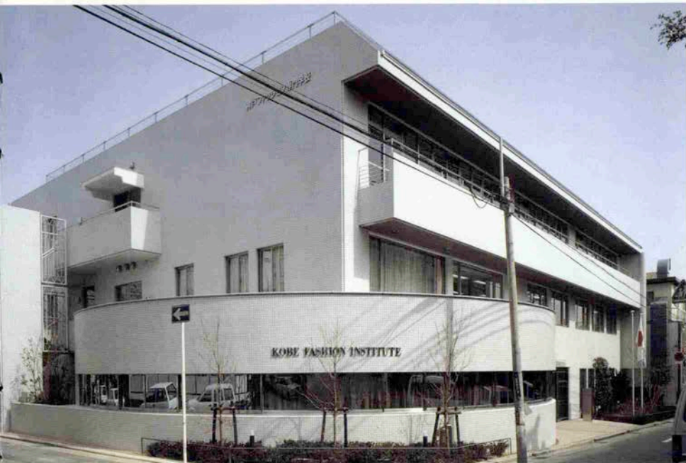
白いタイルの全景
