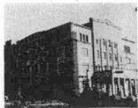
旧神戸商工会議所ビル
