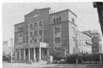
旧神戸商工会議所ビル
