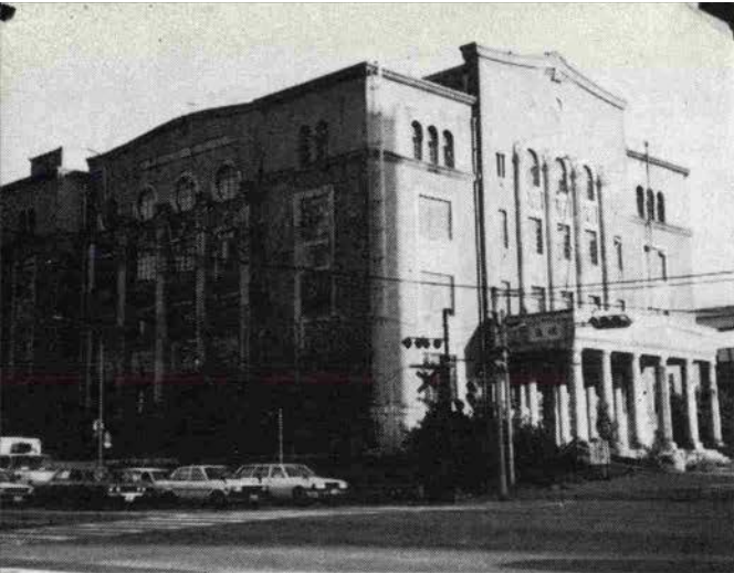
昭和4年に建てられた旧神戸商工会議所
