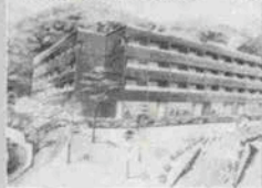
甲南大学理学部棟新築
