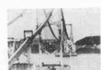
建設中の大鳴門橋
