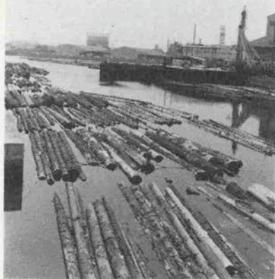
兵庫運河の周辺も再整備が計画されている
