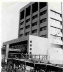
建設中の生田署新庁舎
