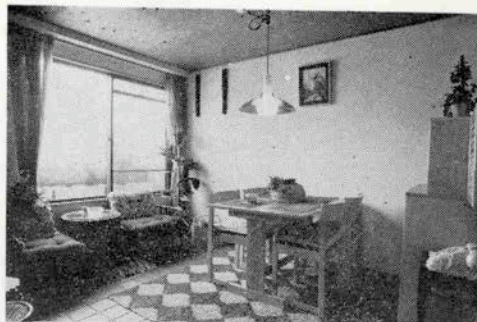
リビングダイニングルーム 床—クリンカータイル 壁—白壁（プラスター） 敷物—花ゴザ 天井—米松
