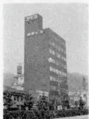
完成した柏井ビル
