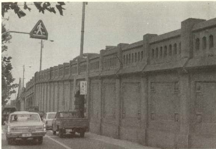
昔からある国道の陸橋、この下でマンホール殺人事件がおこった
