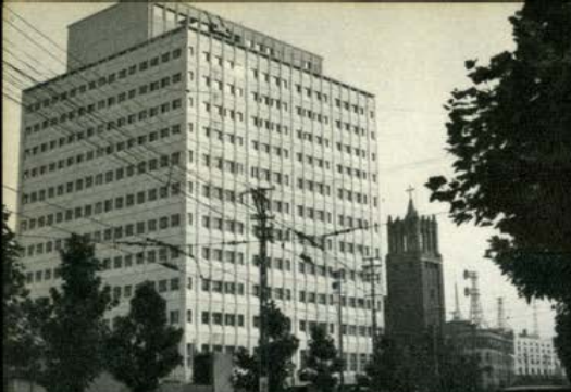
写真左は、県民会館の全貌
