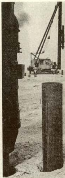
▲工事がはじまった卸売市場
