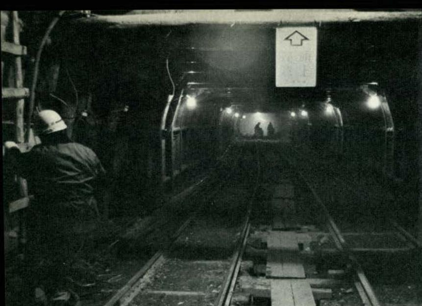
写真上・トンネル工事は岩石に孔をあけ、ダイナマイトで爆破する作業のくり返して、掘進が得られる。
