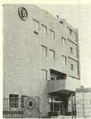
完成したマッチ会館
